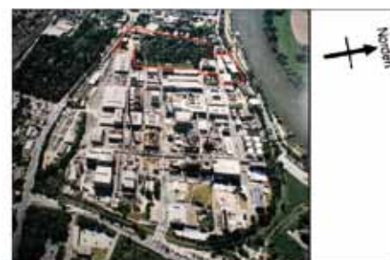
„Clariant-Gelände mit möglichem Gelände für den Energiepol“ Clariant-Gelände mit möglichem Gelände für den Energiepol (rot markiert)
