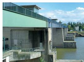
Im Zuge der Mainkanalisierung Ende des 19. Jahrhunderts wurde 1901 die Offenbacher Schleuse als Nadelwehr errichtet. Dabei erfolgte die Regulierung und Stauung des Wasserpegels
