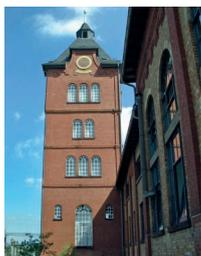
1904 baute das Städtische Gaswerk in unmittelbarer Nachbarschaft zum Hafen ein modernes Gaswerk. Dazu gehört ein im Stil des Historismus mit dekorativem Ziegelmauerwerk errichteter Turm, in dem das durch Kohleverbrennung erzeugte Rohgas abkühlte. Nach Stilllegung der Gasproduktion 1928
