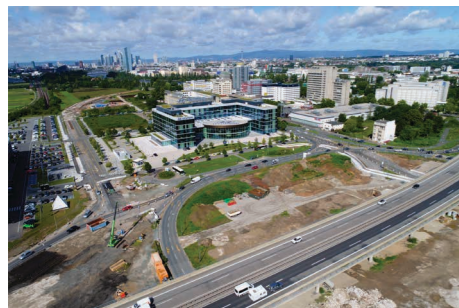
Baustelle am Kaiserlei
