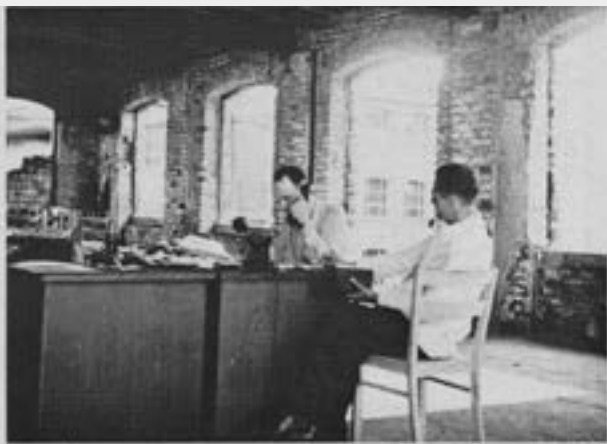
Die Fenster in den Redaktionsräumen waren nicht verglast, die Wände unverputzt. Aber man hatte Telefon.
